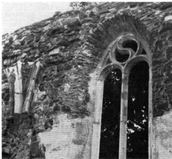
18. Helyreállított szentélyablak és boltozatindítás. 18. Apsisfenster und Gewölbesockel nach Herrichtung. 18. Fenêtre du choeur et naissance de voûte reconstruites. 18. Восстановленное окно святилища и пята свода.
